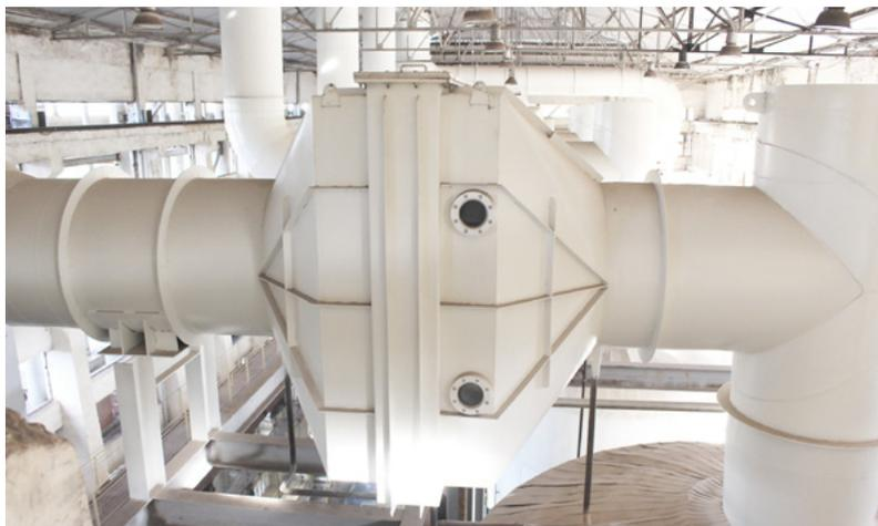
Separador de arraste instalado próximo aos cozedores
