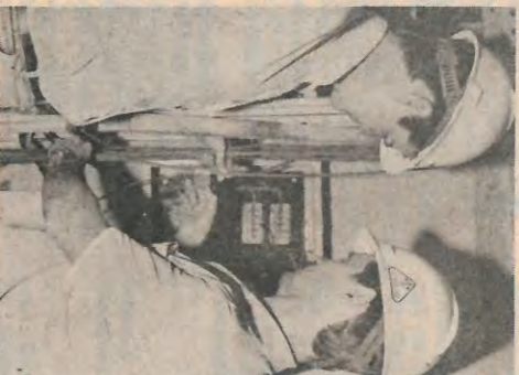
Agenor e Hélio conferem as linhas dos alarmes, agora identificados com fita isolante vermelha.
