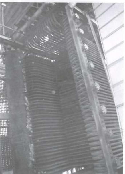
Restou da demolição, a rede de tubulações da parede d'água e o feixe tubular. A parte de alvenaria já foi retirada e o espaço deixado por elas permitirá um estudo de otimização das atuais esteiras de bagaço. A demolição foi realizada pela equipe de geração de vapor.
