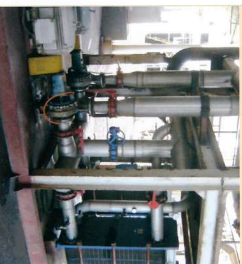
No trocador de calor a energia térmica da vinhaça aquece o caldo da moenda
