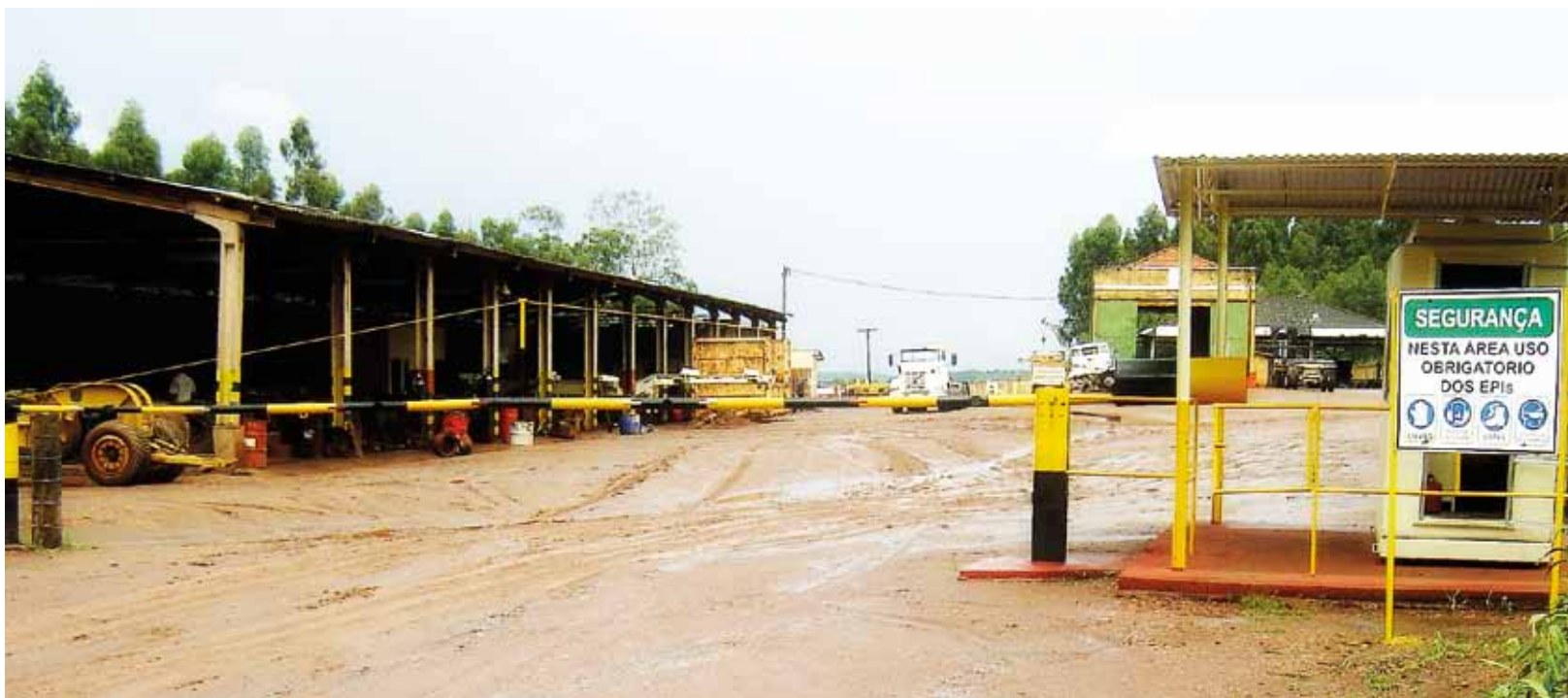
Novo prédio da oficina garante condições adequadas de trabalho
