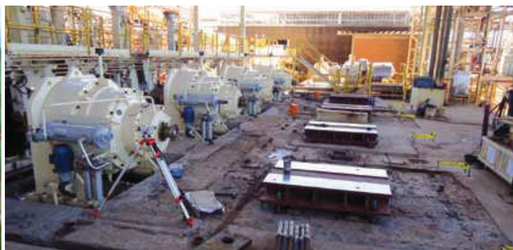
Usina Buriti realiza a troca das turbinas a vapor da moenda por motores elétricos
