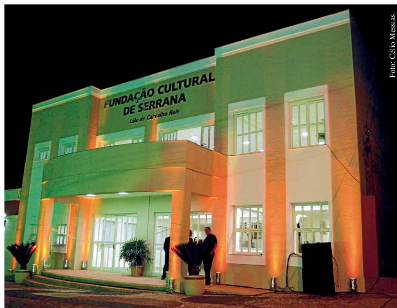
Nova fachada da Fundação Cultural de Serrana
