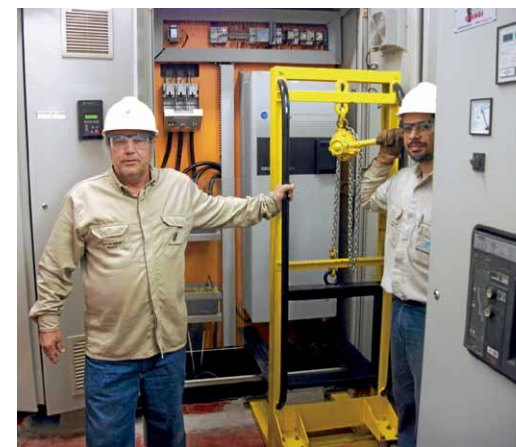
Equipe trabalha em novo equipamento na Ibirá
