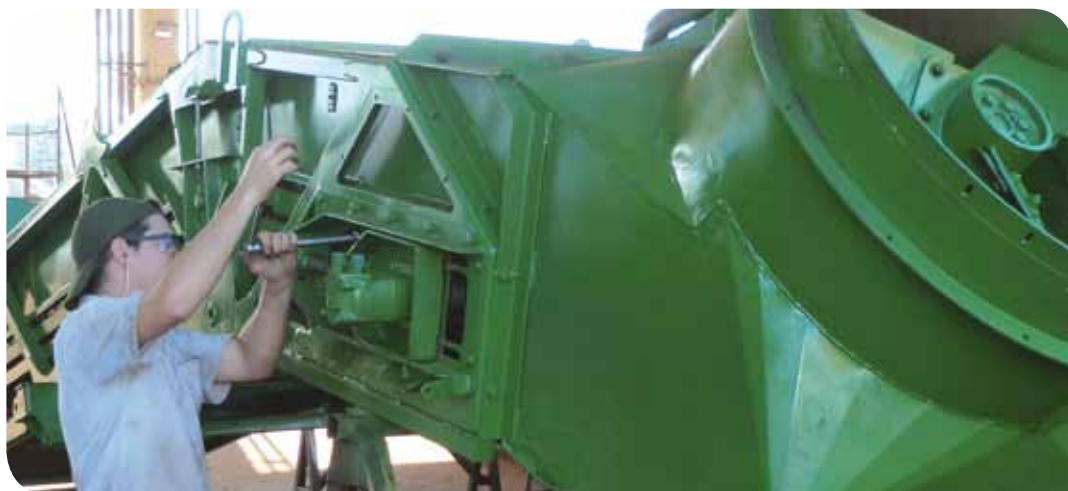
Funcionário realiza manutenção na Usina Ipê
