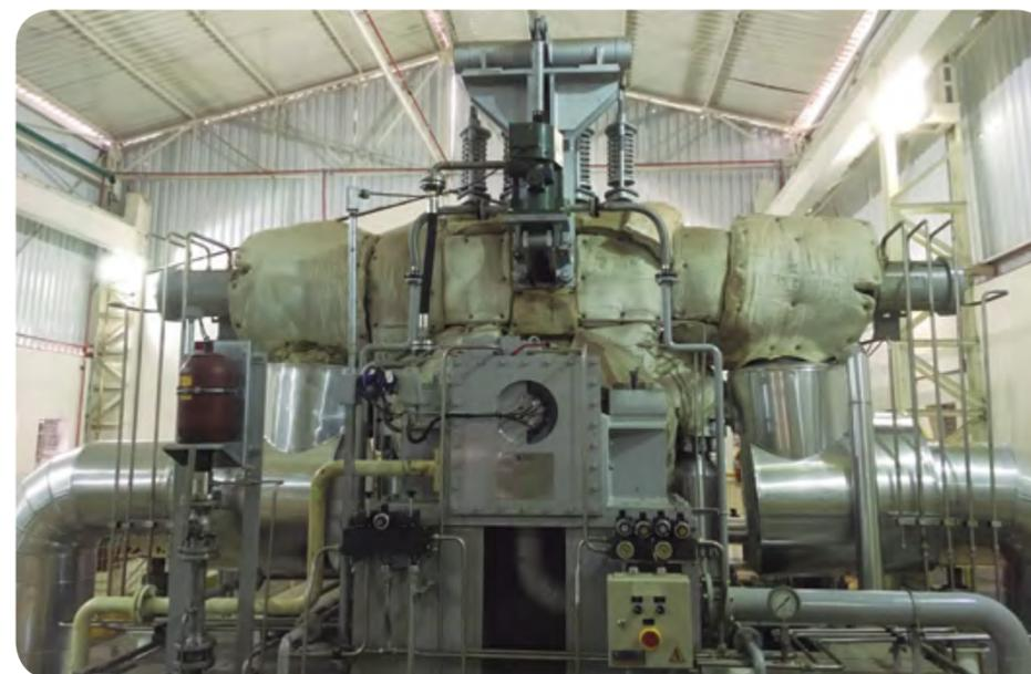
Novo turbo-gerador da Usina Buriti: equipamento possui 25MWh com tecnologia de contrapressão
