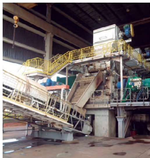
Construção de novo terno de moenda é um dos investimentos na área industrial da Usina Ipê
