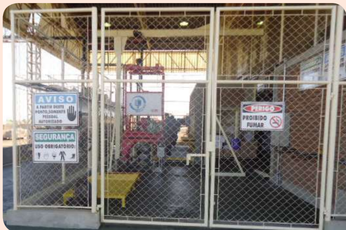
Nova instalação do preparo de defensivos na Usina Buriti
