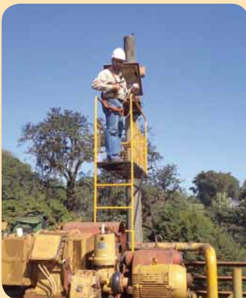
O eletrícista, Mauro José de Santana, realiza troca das lâmpadas com a plataforma móvel
