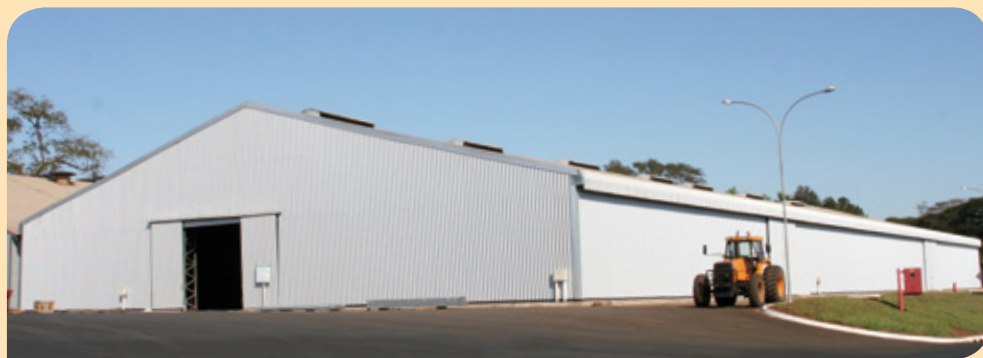
Depósito de Açúcar n. 7 após a reforma
