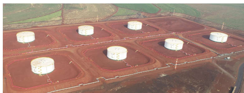
Acima, as novas instalações dos depósitos de açúcar e os novos tanques de etanol, na Usina da Pedra
