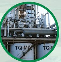
**Destilação e Desidratação:** Separação do vinho em vinhaça, flegmaça e etanol, resultando no etanol hidratado (teor alcoólico de 95 a 96,5° GL). Para a produção do etanol anidro é realizada a remoção da água através de peneiras moleculares com resinas zeólitas, resultando no etanol anidro (teor alcoólico de 99,3 a 100° GL).
