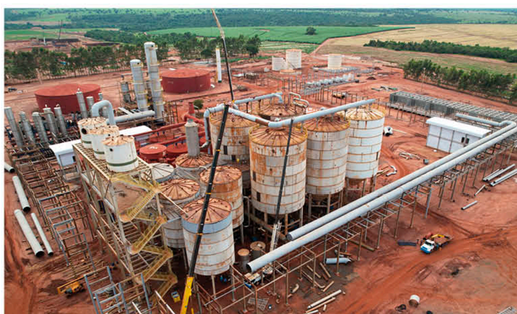
Instalação dos equipamentos da Fermentação e Destilaria.
