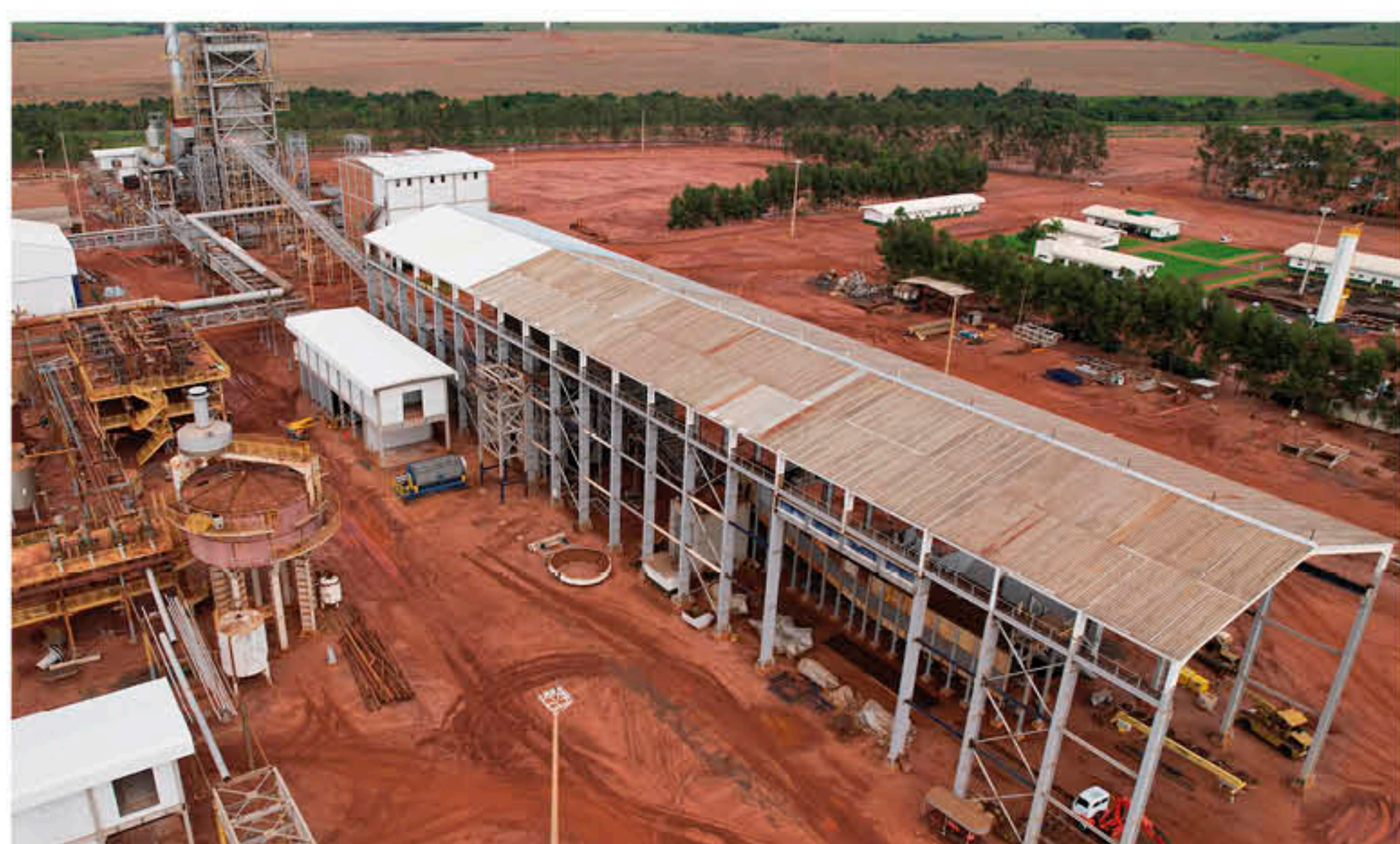
Estágio atual das obras do Barracão da Moenda.
