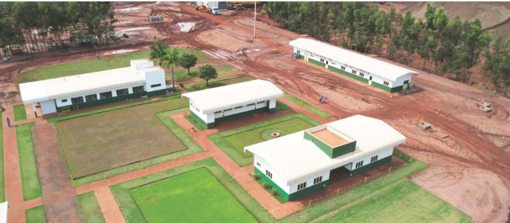
À esquerda e ao centro o Escritório Industrial, Refeitório, Serviço Social, Saúde Ocupacional, Segurança do Trabalho e à direita o Laboratório Industrial.
